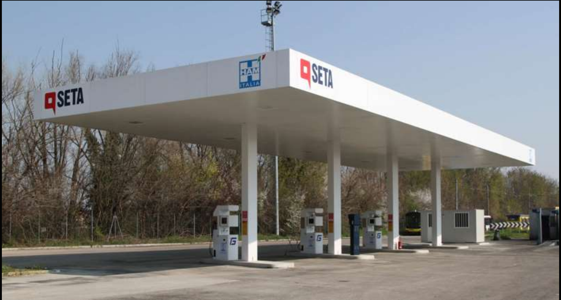
L'impianto GNL-C più grande e innovativo d'Europa, la Seta di Modena: 100 m 3 , 3 erogatori metano grande portata con impianto che rifornisce 130 Kg in meno di 5 minuti
